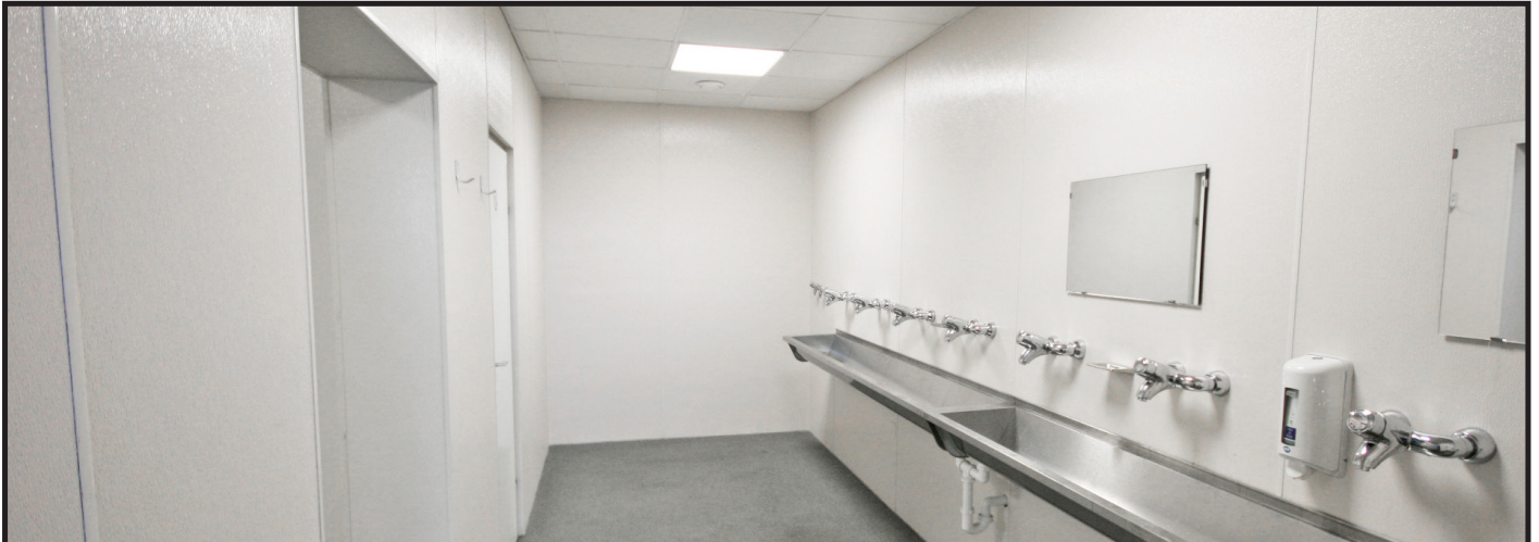
Hydewa Renovierungspaneel - bestehend aus einem Kern (EPS oder PIR) mit beidseitigen Deckschichten.
